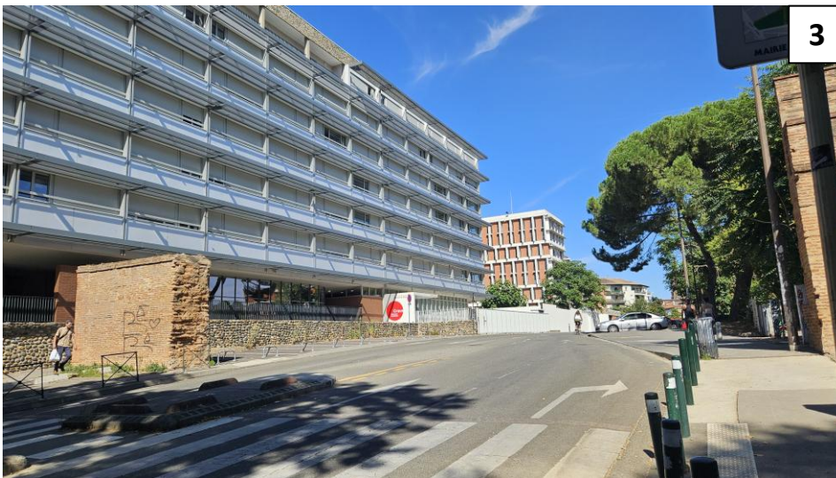
Vue depuis l'intersection entre le Boulevard Armand Duportal et la rue de l'Université au Sud-Ouest du projet (SOLER IDE – août 2025)
