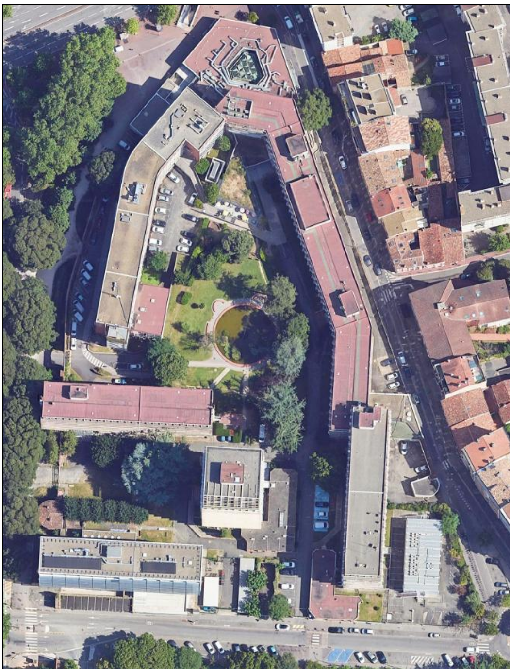
Figure 3 : Photographies aériennes du site d'implantation du projet
