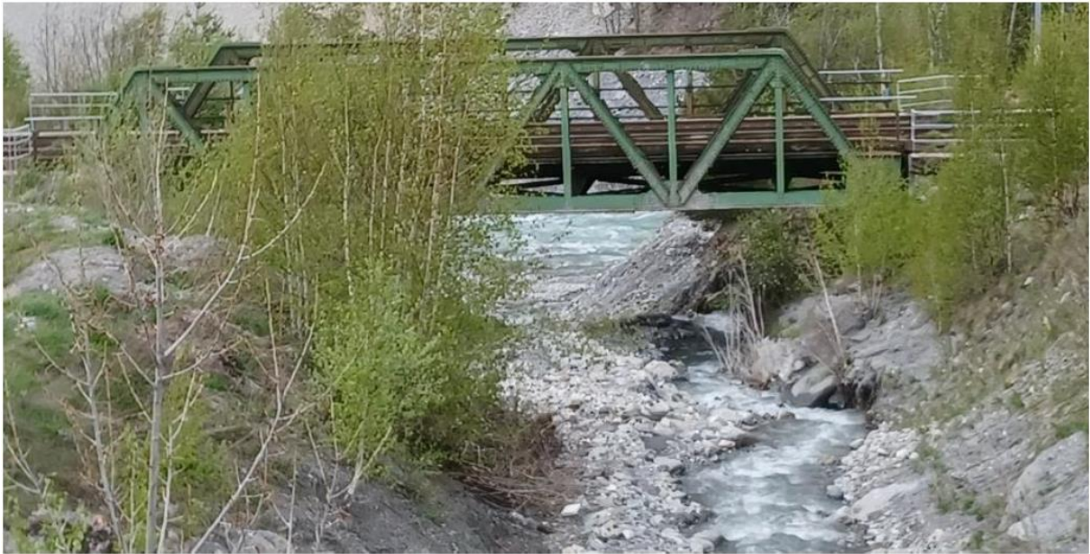
Figure 13 : Pont SNCF, avril 2024 (Source : AVP Phases 1 et 2 – Etude hydraulique)
