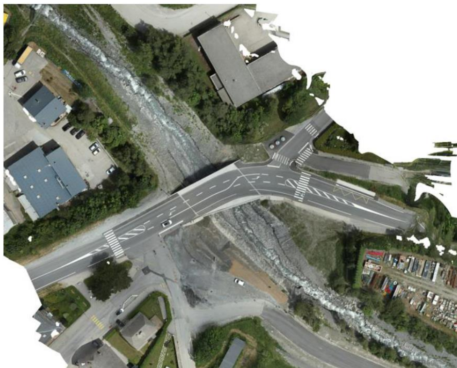
Figure 11 : Orthophoto au droit du pont de la RD (VR3D) (Source : AVP Phases 1 et 2 – Etude hydraulique)
