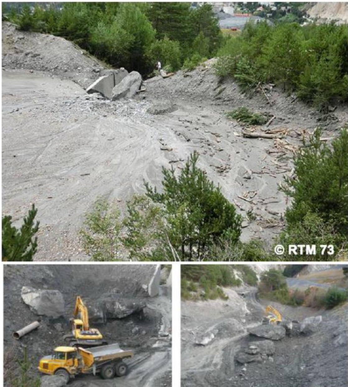
Figure 7 : Plage de dépôt suite à la crue de 2014 (Sources : ONF-RTM et ETRM 2018)
