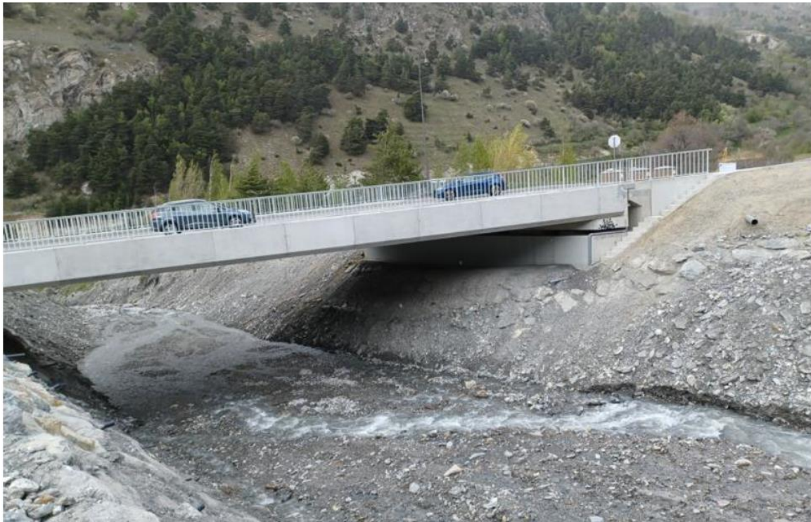
Figure 10 : Pont de la RD 1006 avril 2024 (Source : AVP Phases 1 et 2 – Etude hydraulique)
