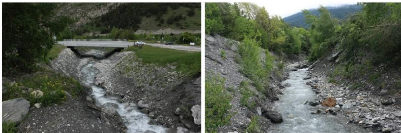
Figure 45: Photographies du torrent du Saint-Antoine en amont de la zone d'étude (Source : Améten, 21/05/2025)
