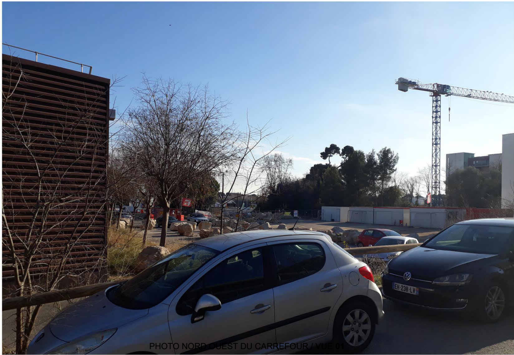
PHOTO NORD-OUEST DU CARREFOUR / VUE 01
