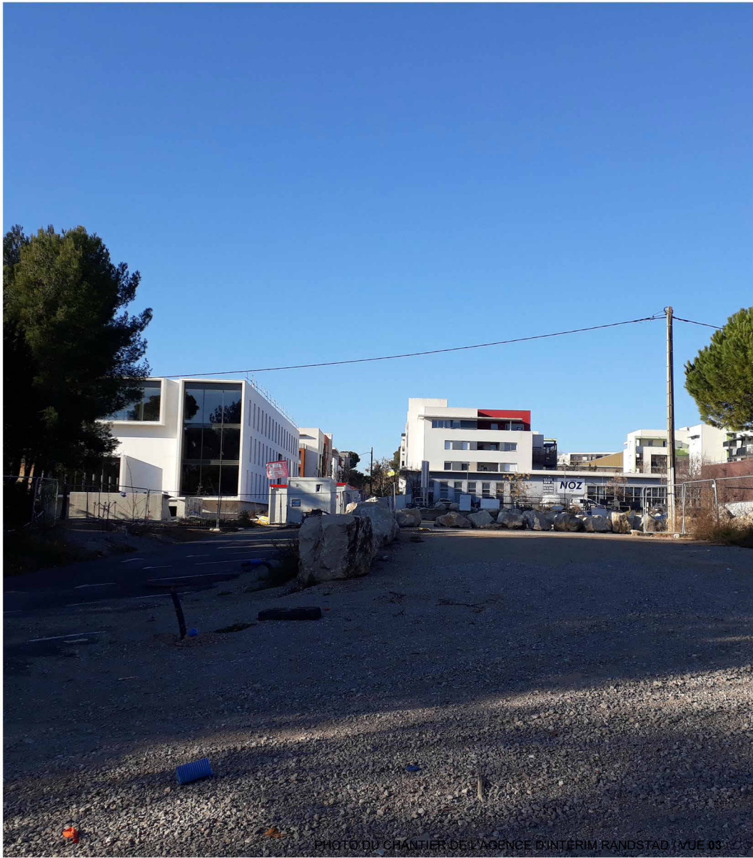
PHOTO DU CHANTIER DE L'AGENCE D'INTERIM RANDSTAD / VUE 03
