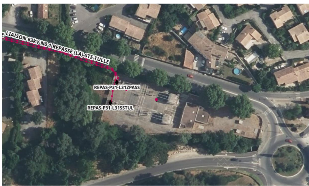
Figure 2 : Vue aérienne du poste électrique de LA REPASSE
