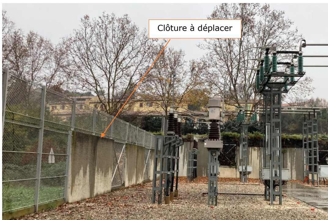
Figure 4 : Photos de la clôture à déplacer sur le poste électrique de LA REPASSE
