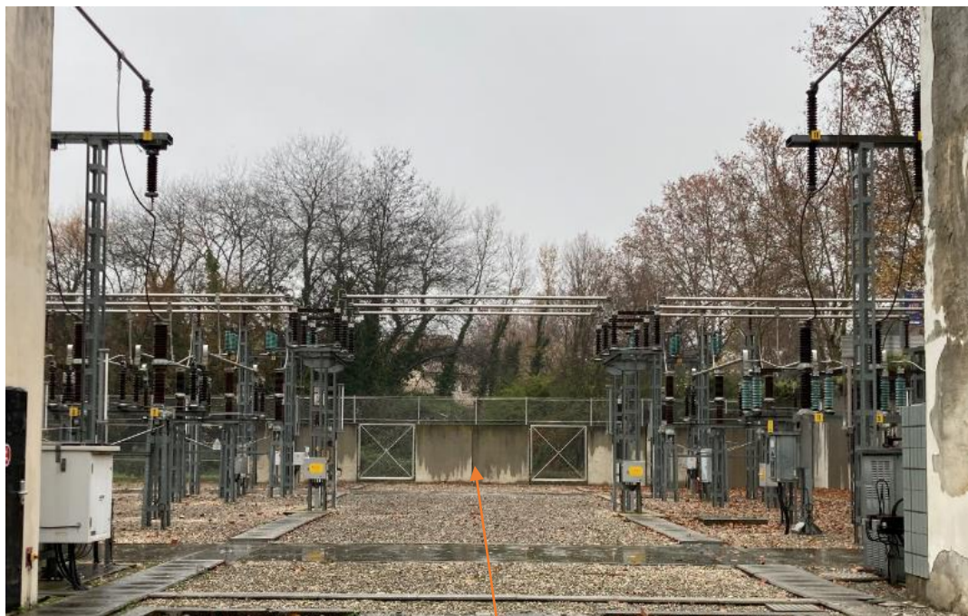
Clôture à déplacer
