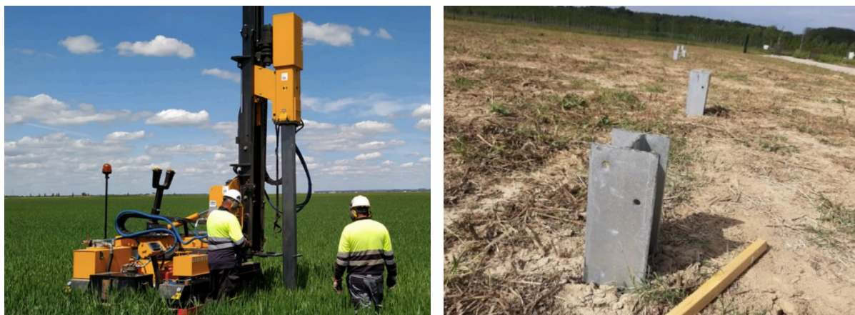
Figure 6 : illustration de travaux de de fondations avec pieux battus
