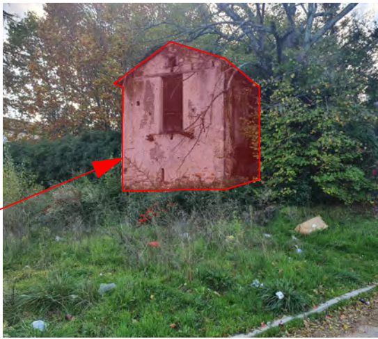
vue bâti démoli
