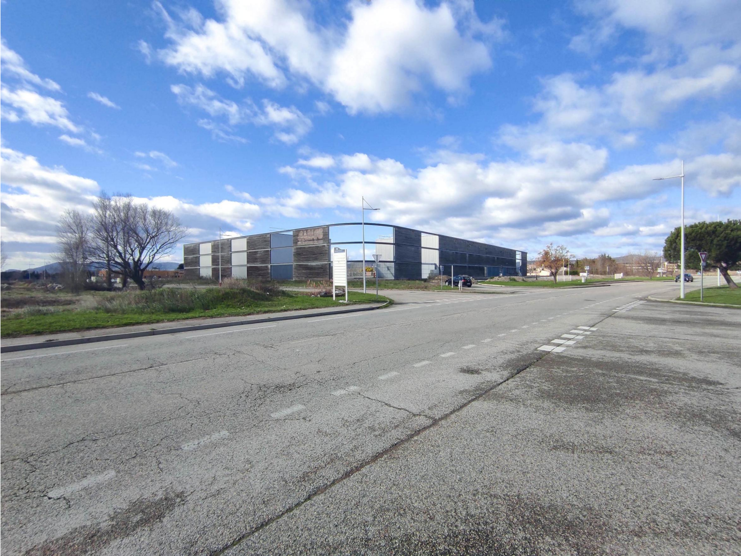
vue 1 - vue du terrain depuis le boulevard Charles André au Nord-Est
