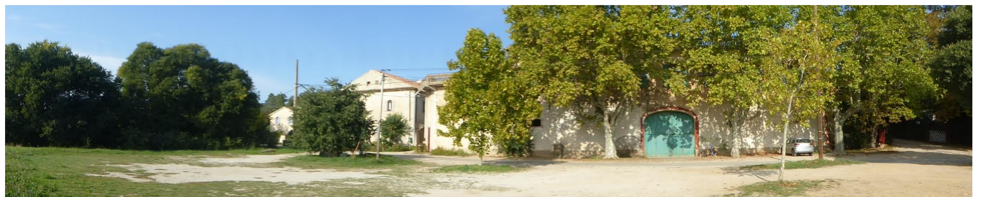
Photo 15 – Le long du bâtiment authentique du grand-St-Mitre bien inscrit dans les hauts platanes, le site à gauche de l'image n'est pas perceptible.
