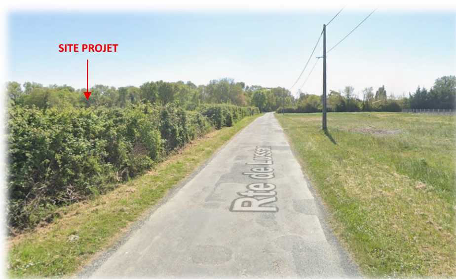
Figure 33 : Vue de la route de Lussan vers le Sud (Source : GoogleStreetView 2021)
