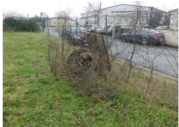
Clôture et vue sur la rue Jean Perrin au sud
