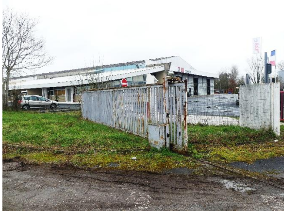
Portail et accès au site (ECTARE, février 2026)
