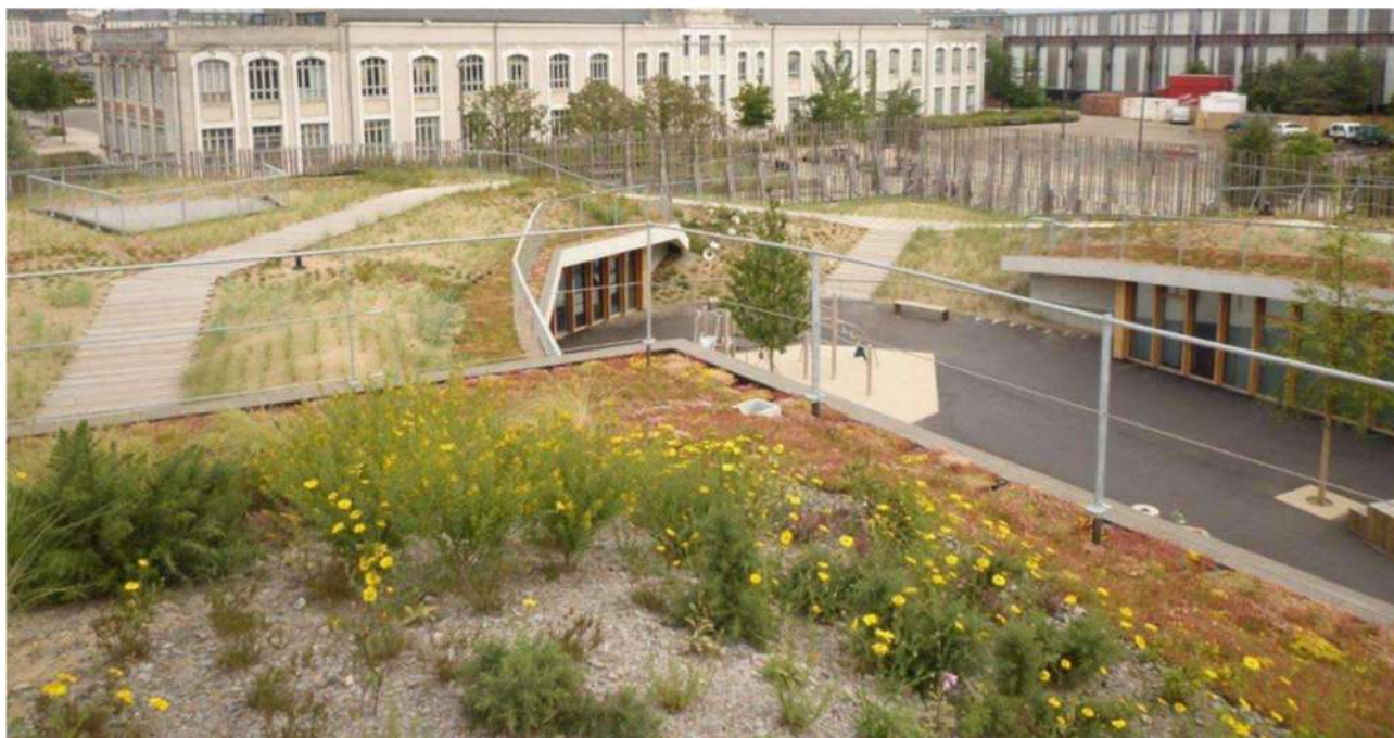
Figure 8 : Habitat de friche sur sable recréé en toiture – illustration 2/2
