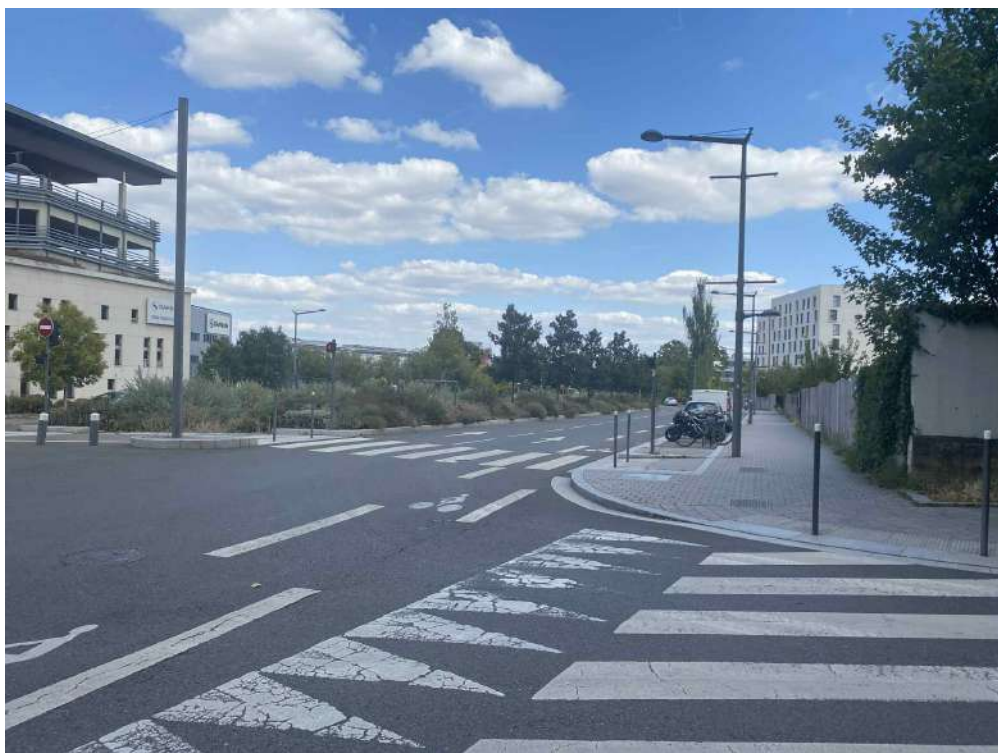
Photographie 2 : Vue du site depuis l'avenue de Paris (2/3)
