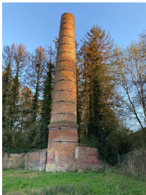
Illustration 10. Ancienne cheminée de la friche Stiona - Source : Verdi
