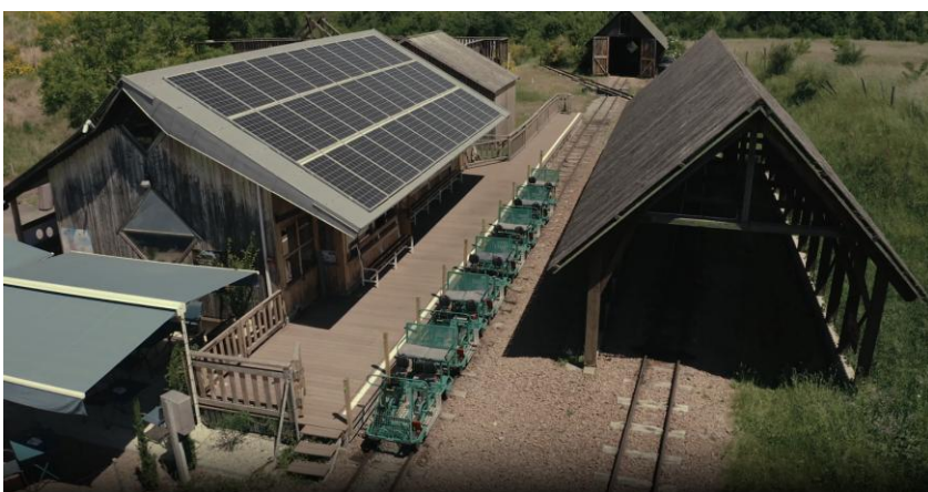
Vue sur le bâtiment d'accueil et le bâtiment technique
