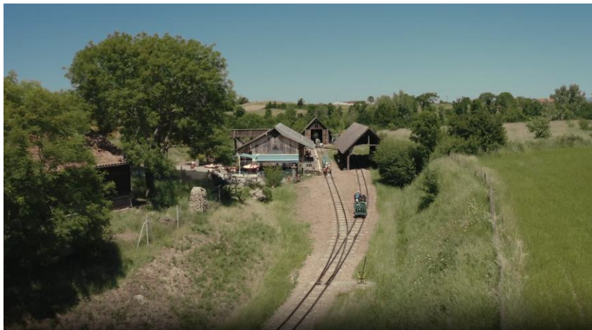
Vue sur le site d'accueil depuis le Sud
