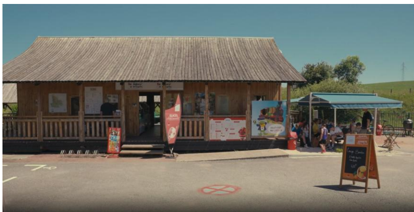
Vue sur le bâtiment d'accueil
