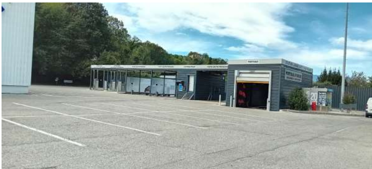
Figure 4 : Photographie de la station de lavage auto
