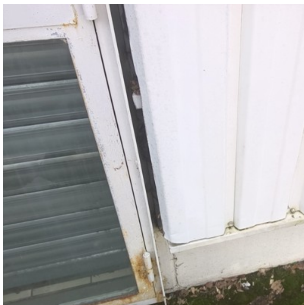
N ENVELOPPE / FAÇADES / Bac acier [ Prélèvement n°92]
