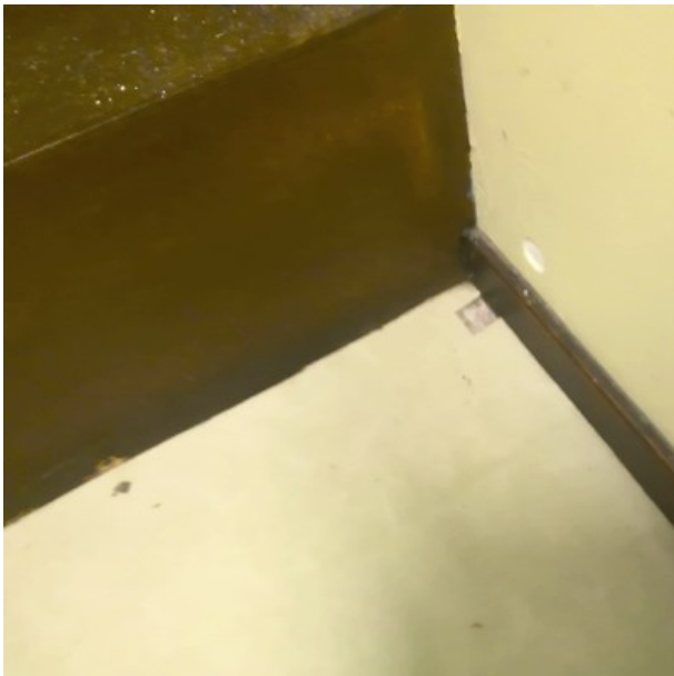
N R+1 / VESTIAIRES HOMMES / Sol souple (sup) + Colle + Sol souple (inf) + Colle + Ragréege [ Prélèvement n°9] [ Idem Prélèvement n°2]
