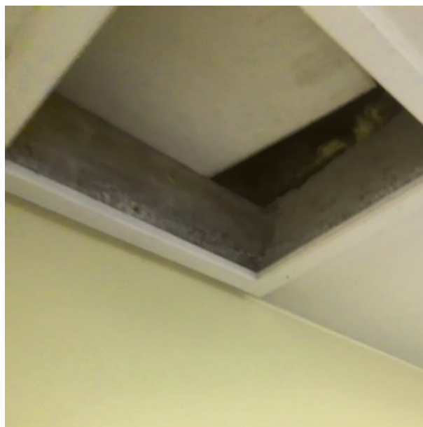
N COMBLES TOITURE / Pare-Vapeur + Colle + Isolant type laine [ Prélèvement n°1]
