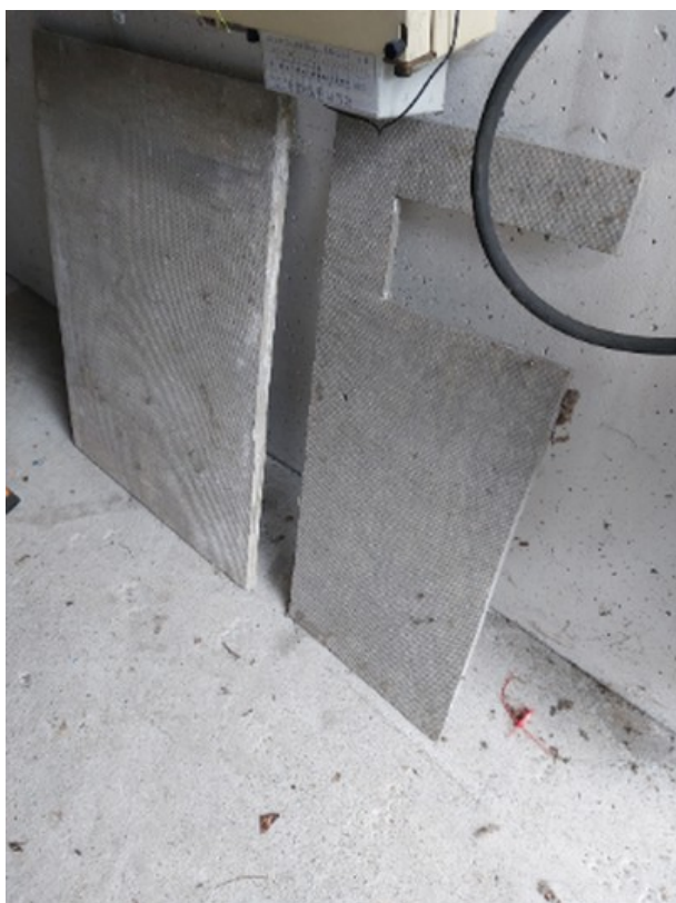
a RDC / LOCAL TRANSFORMATEUR / Plaque en fibres-ciment [ Prélèvement n°106]
