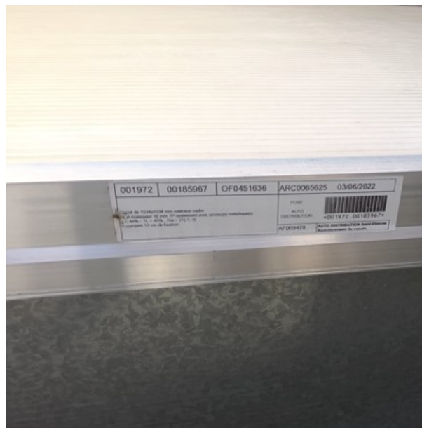
N ENVELOPPE / TOITURE / Mastic Skydome
