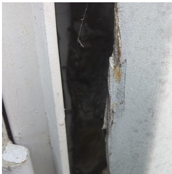
N ENVELOPPE / FAÇADES / Isolant type laine [ Prélèvement n°93]
