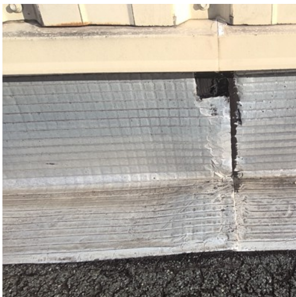
N ENVELOPPE / TOITURE / Etanchéité bitumineuse type paxalu [ Prélèvement n°88]
