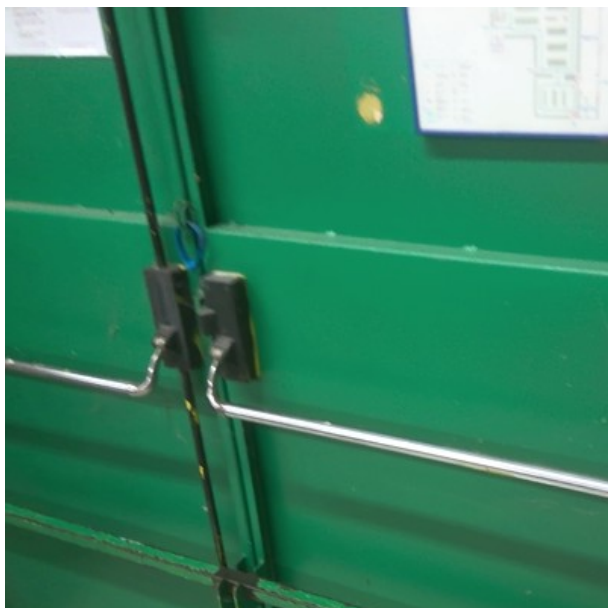
N RDC / SURFACE DE VENTE / Peintures sur porte secours métal [ Prélèvement n°76]
