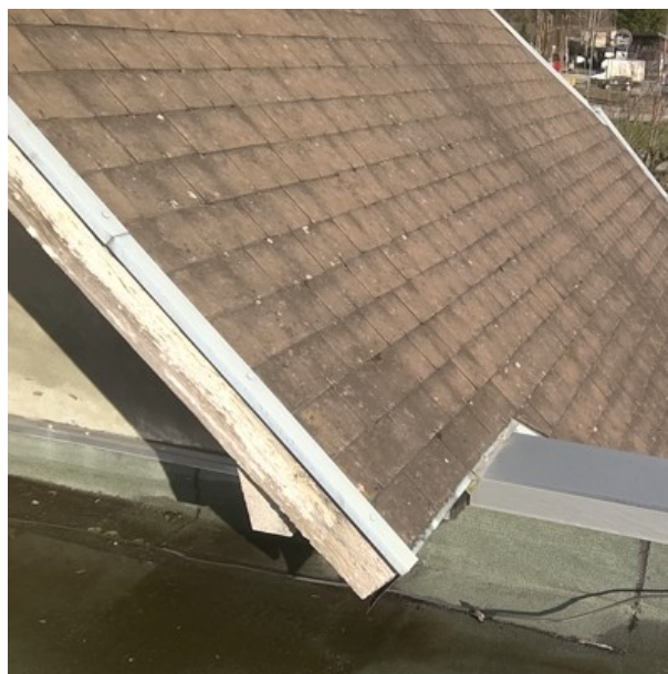
a ENVELOPPE / TOITURE / Ardoise en fibres-ciment [ Prélèvement n°89]
