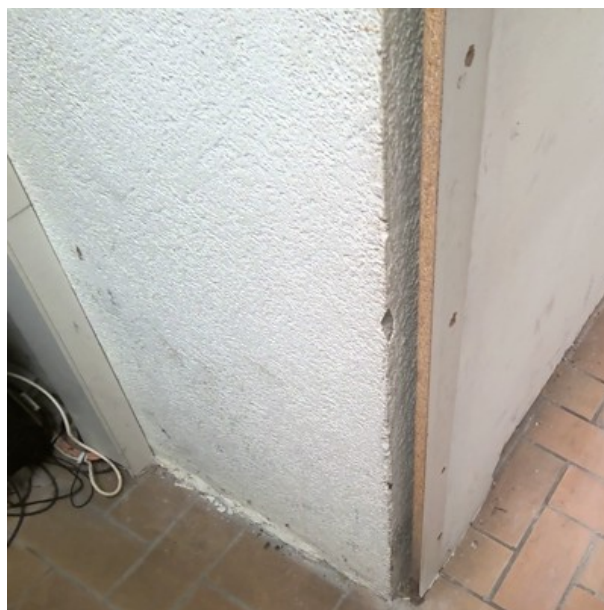
N RDC / LOCAL TECHNIQUE / Peintures + Enduit type ciment (refend) [ Prélèvement n°41]
