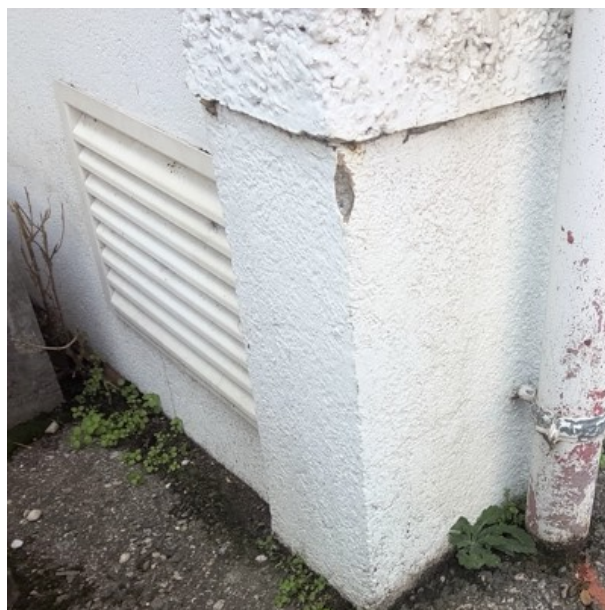
N ENVELOPPE / FAÇADES / Peintures + Enduit type ciment [ Prélèvement n°91] [ Idem Prélèvement n°90]
