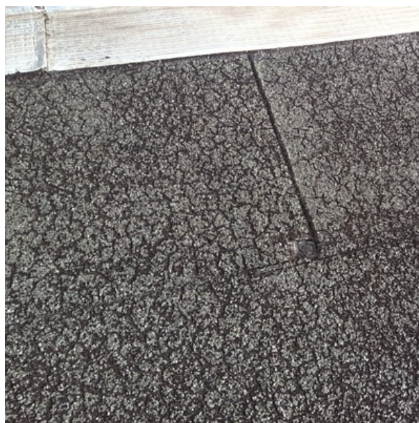
N ENVELOPPE / TOITURE / Etanchéité bitumineuse [ Prélèvement n°87]
