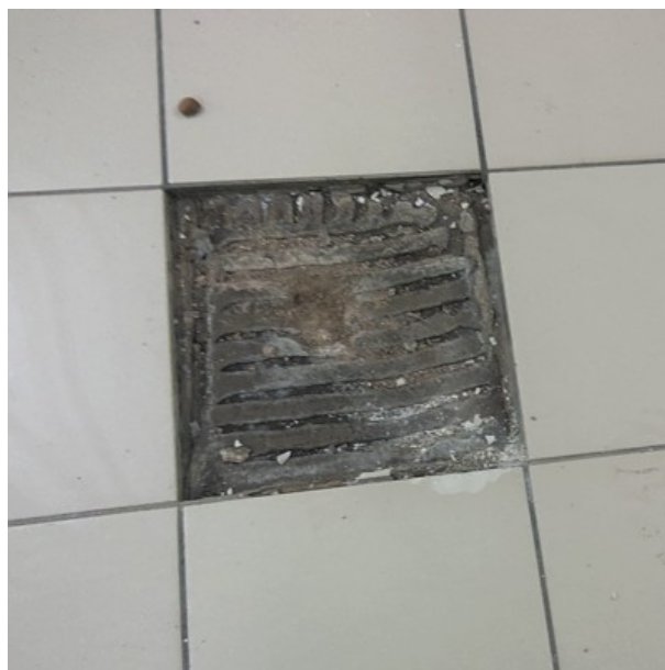
N RDC / SURFACE DE VENTE / Colle + Joint de carrelage (sup) [ Prélèvement n°74]
