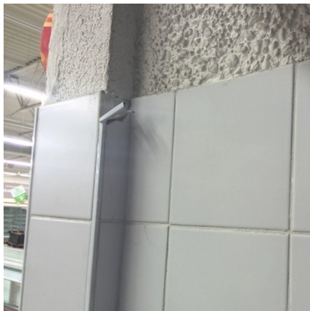
N RDC / ENTREE-CAISSES / Colle + Joint de faïence carrelage (poteaux) (blanc grand carreaux) [ Prélèvement n°59]
