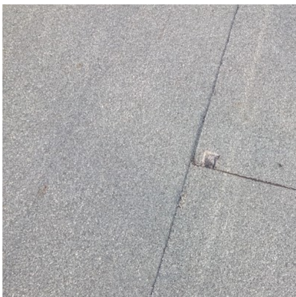
N ENVELOPPE / TOITURE / Etanchéité bitumineuse [ Prélèvement n°86]
