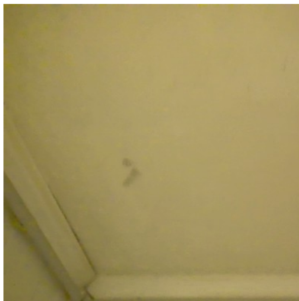
N RDC / ATELIERS / DGT / Peintures + Enduit [ Prélèvement n°81]
