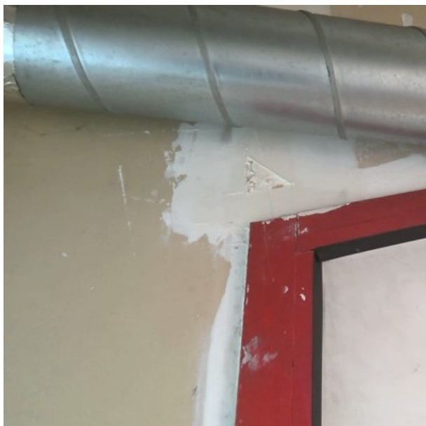
N RDC / LOCAL TECHNIQUE / Enduit de jointoiment des plaques de plâtre + Calicot [ Prélèvement n°42]
