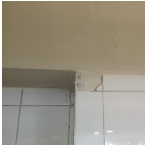
N RDC / SURFACE DE VENTE / Colle de faïence (fromager/boucherie) [ Prélèvement n°79]
