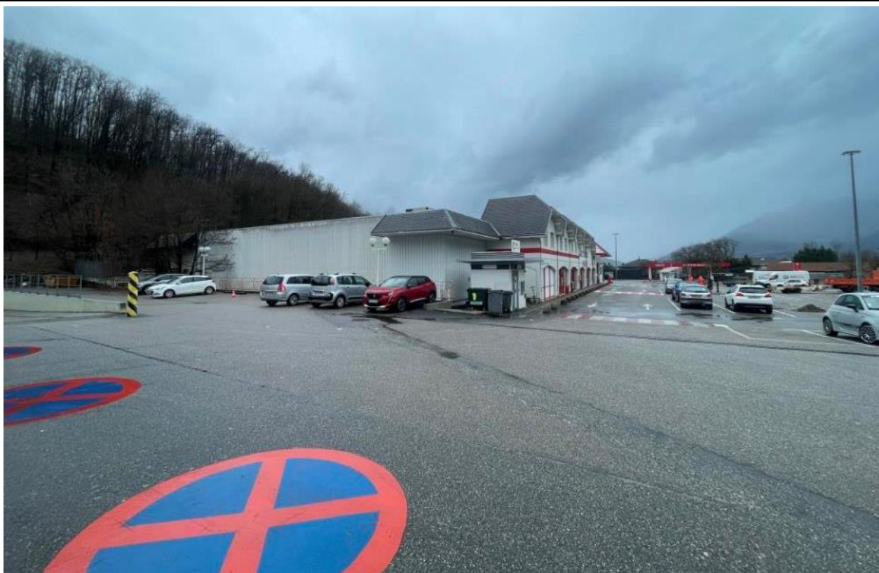
Photo générale du site (vue vers le Nord, au niveau de la façade avant du bâtiment existant)
