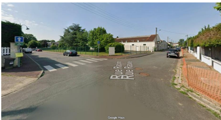
33 – Rue Racine (juin 2025) À la proximité de l'intersection rue Boileau
