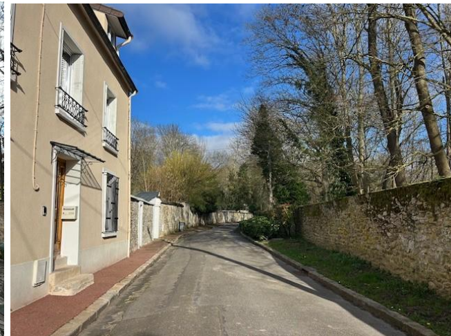
29 – Rue de l'Eglise (Février 2026) Au sud
