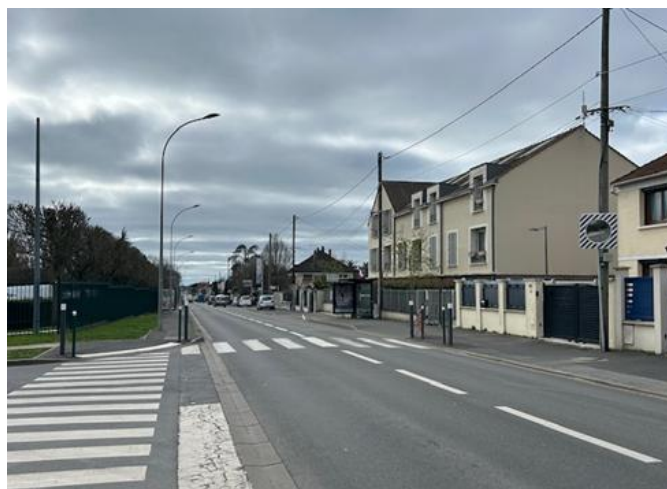
21 – Avenue Wladimir d'Ormesson (Fév. 2026) À la proximité de l'intersection rue A. Pinay
