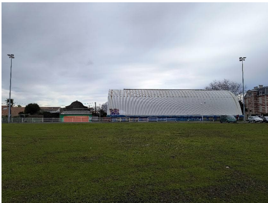
FIGURE 9 : VUE DU TERRAIN VERS L'EST
