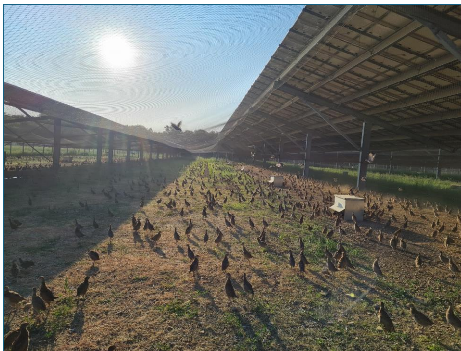
Figure 2 : Volière photovoltaïque. (Source : Technique Solaire)
