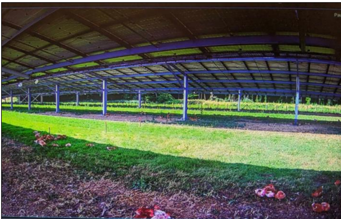
Figure 17 : Photographie du parcours extérieur lors d'un jour de forte chaleur ( T_{air} = 30^{\circ}\text{C} ) lors duquel les poulets fréquentent préférentiellement les zones d'ombre apportées par les panneaux solaires. Les zones ensoleillées sont désertées.
