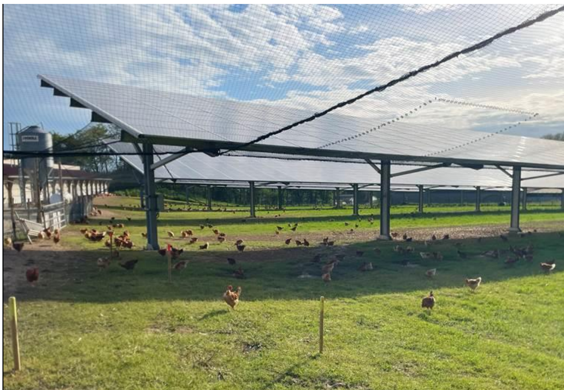
Figure 12 : Photographie d'une volière photovoltaïque Technique Solaire (47) dans le cas d'un élevage de poulets de chair, avec à gauche le bâtiment d'élevage relié directement aux panneaux solaires et à la clôture périphérique, formant un clos total.
