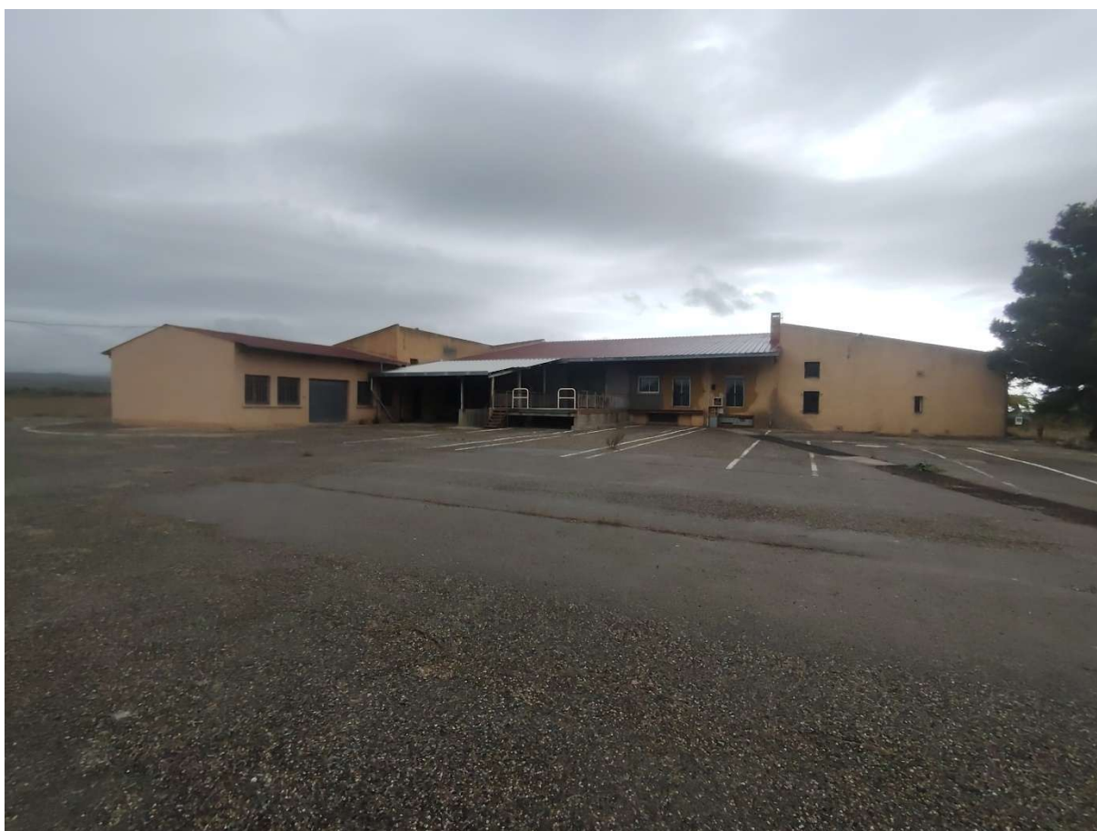
Photo 1 (L. BERNARD, 6 novembre 2025) : vue sur l'ancien bâtiment AFPA à démolir
