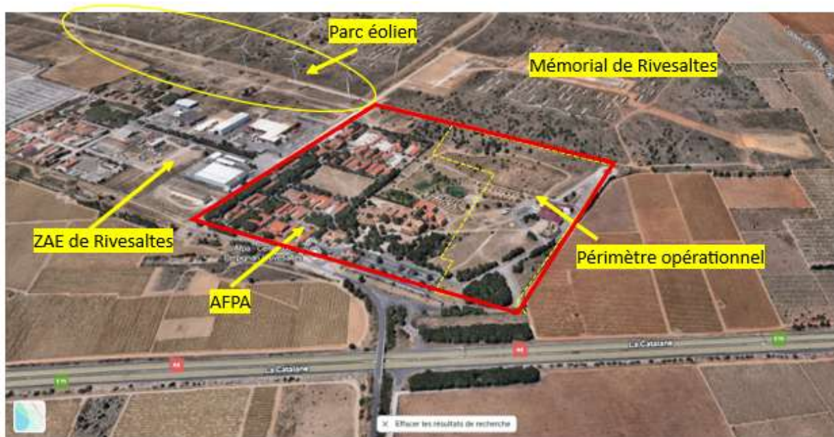
Figure 12 : Photographie aérienne du site avec les équipements en présence
