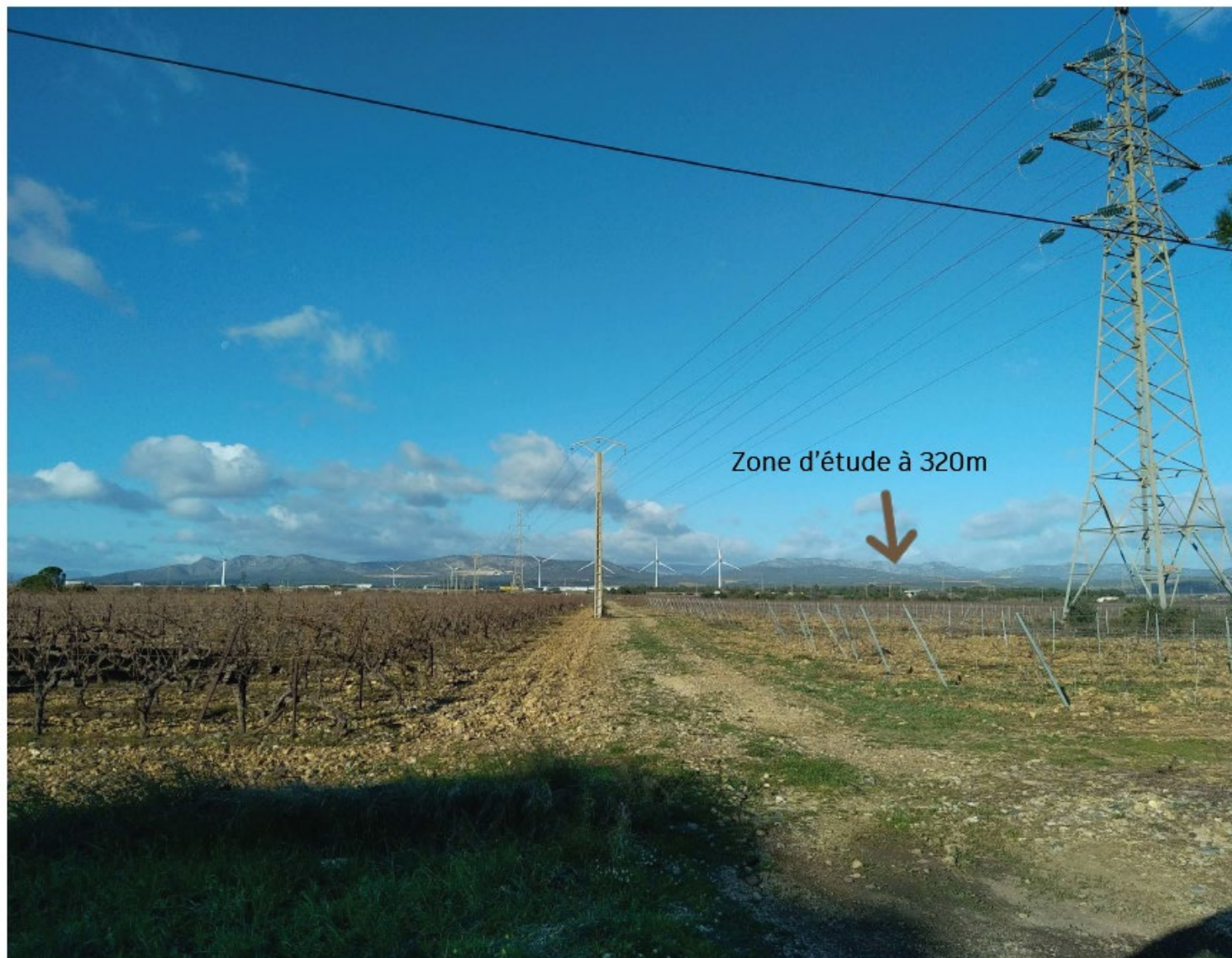
■ Photographie 3 : Vue depuis la RD900 au Sud-Est (12/2024)
