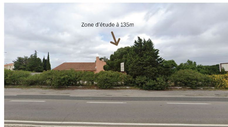
Vue n°4, sur la route départementale 900 Localisation du projet : Ouest
