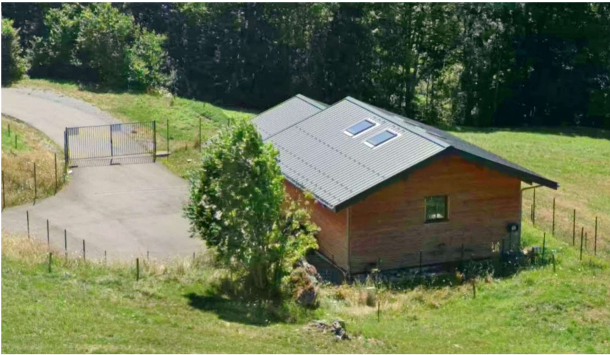
Photo de l'UDEP – Habillage bois, toit en bac acier
