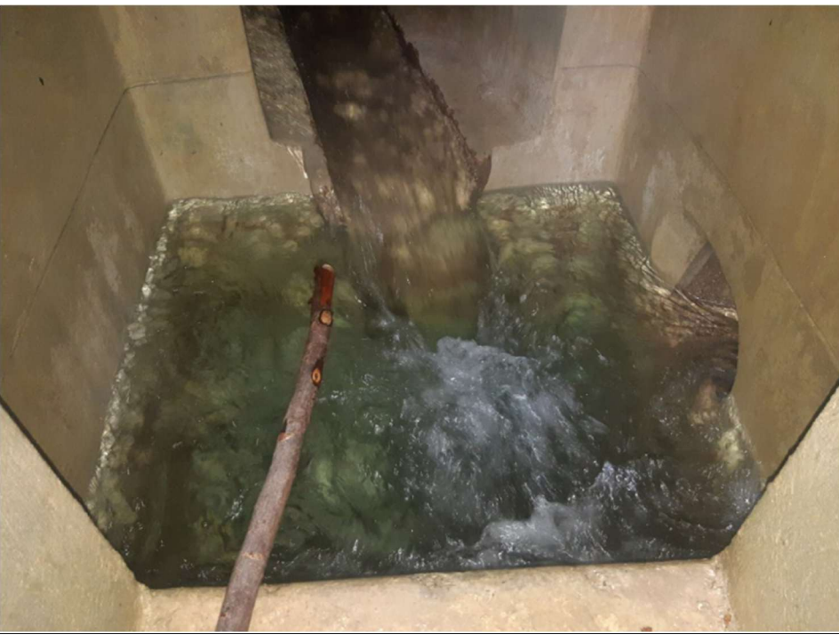
Intérieur du captage
