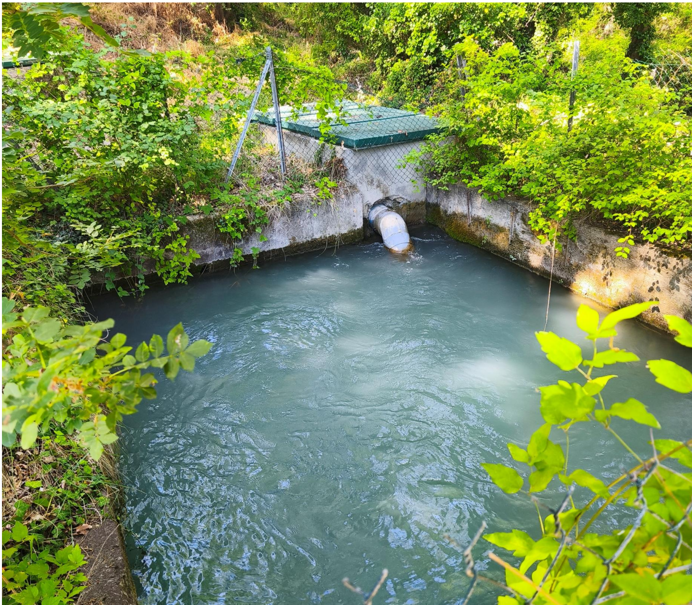
Bassin de tranquillisation avec conduite et édicule contenant les vannes – 18 juillet 2025
