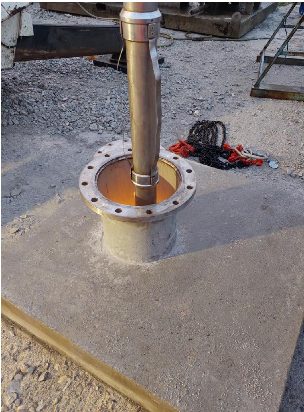
Photo 1 : Photo du forage de Toulenne (inspection vidéo du 12/12/2025)
