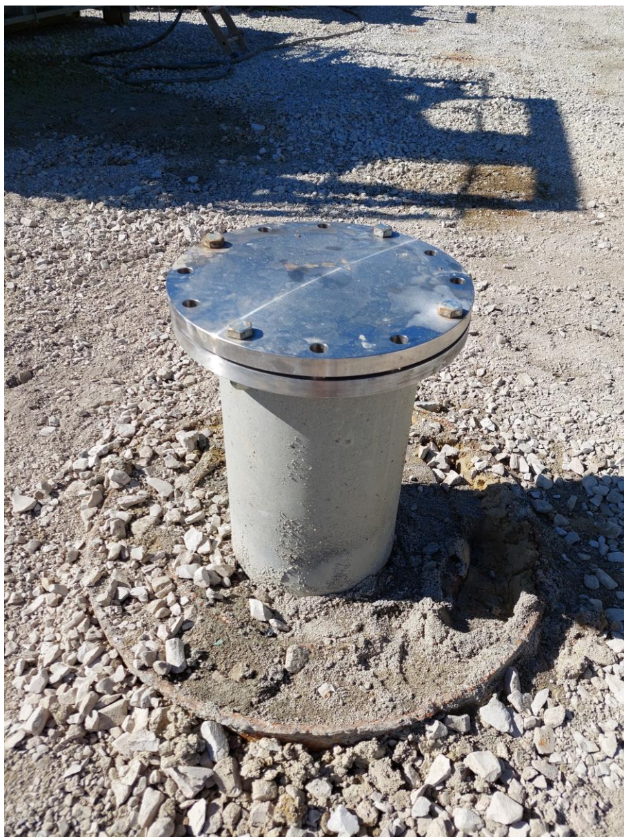
Figure 3 : photo du forage avec bride fermée au 09/10/2025
