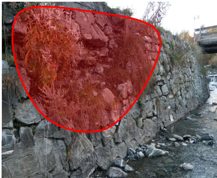
Figure 3 : Secteur de mur à faire tomber et à reconstruire.
