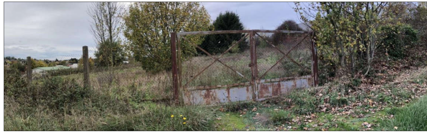
Photo n°9 : Accès à la parcelle 391
