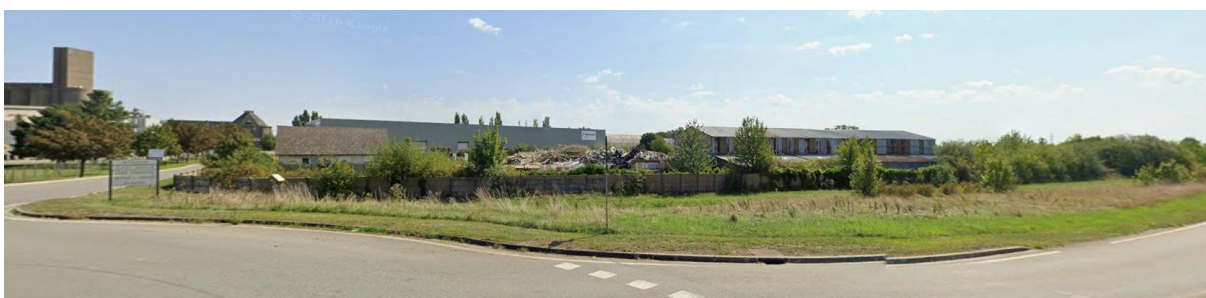
Vue de l'entreprise SF28 depuis le giratoire direction Lhopiteau – source : Google Maps
