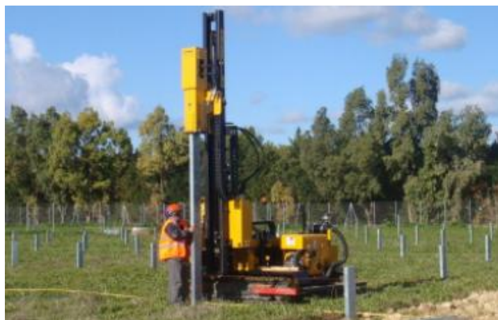
Ancrage des pieux battus
