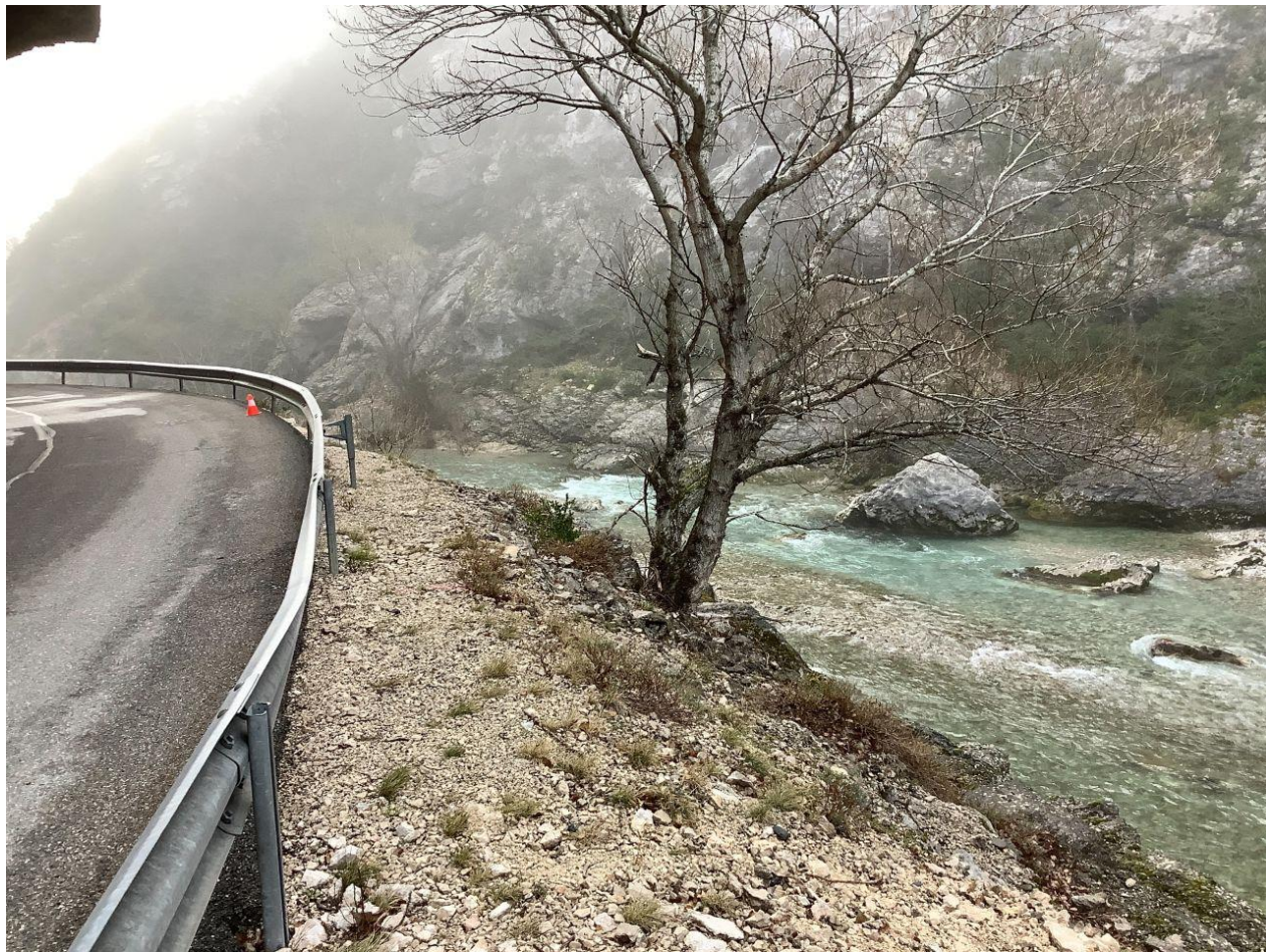
Photo 9 – Mur 2-vue de dessus – BOAS-09/2021
