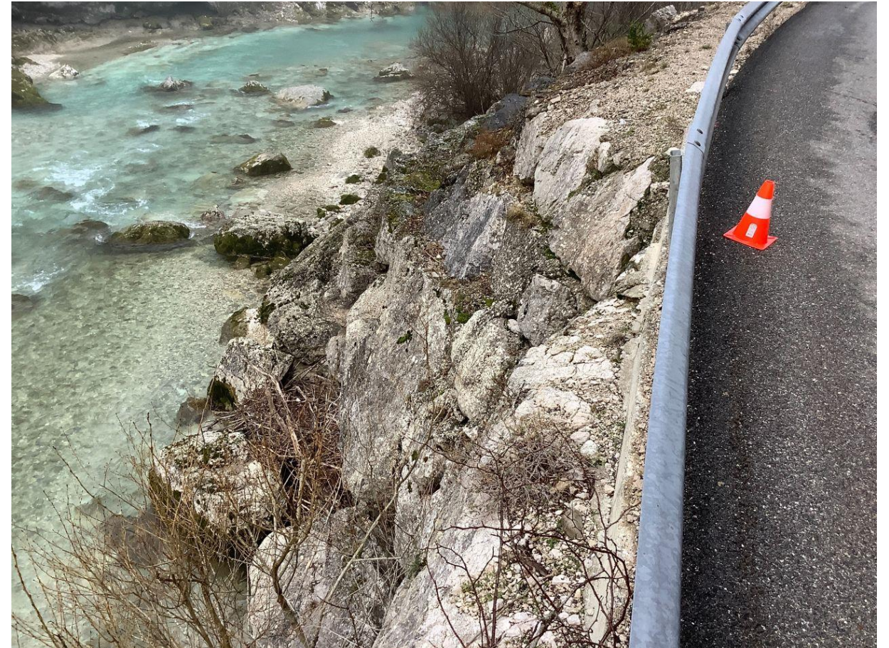
Photo 6 – Mur 2-vue de dessus – BOAS-09/2021
