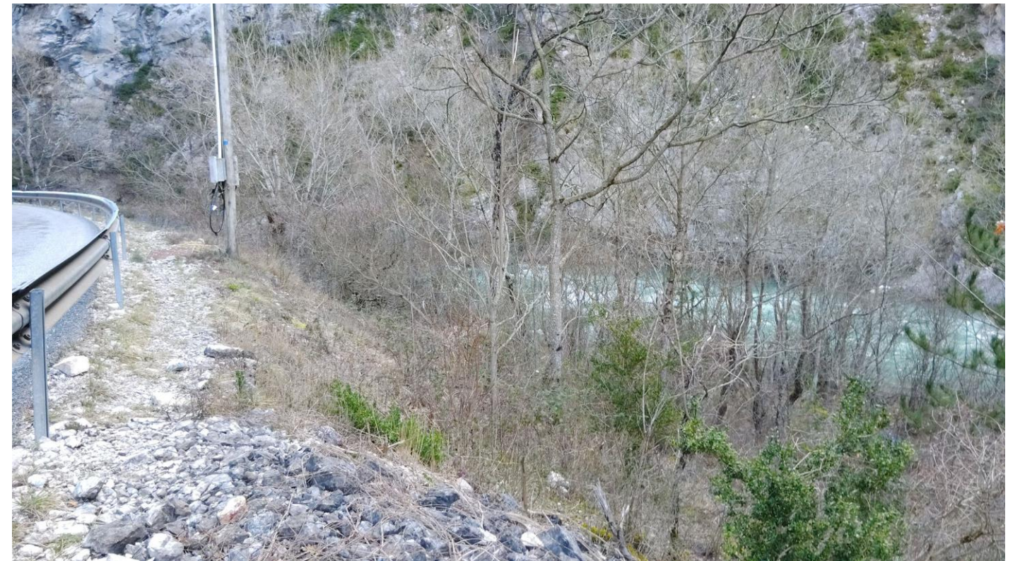
Photo 10 – Accès-vue de dessus – CD04-02/2026
