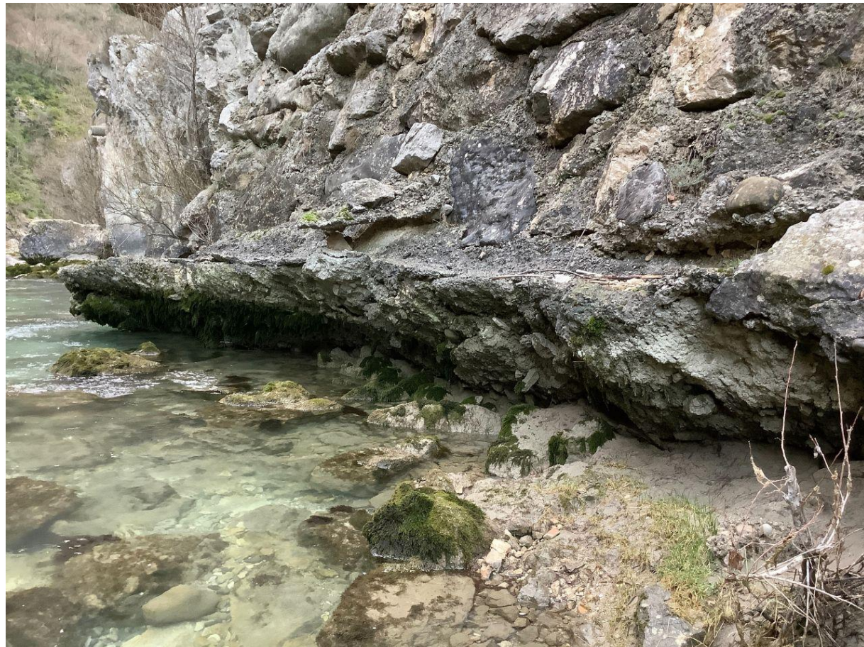
Photo 5 – Mur 1-vue de l'affouillement – BOAS-09/2021
