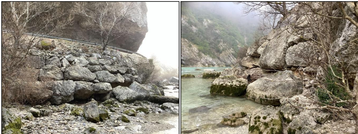
Figure 4 : Photographie de la portion RD952 PR8+820
