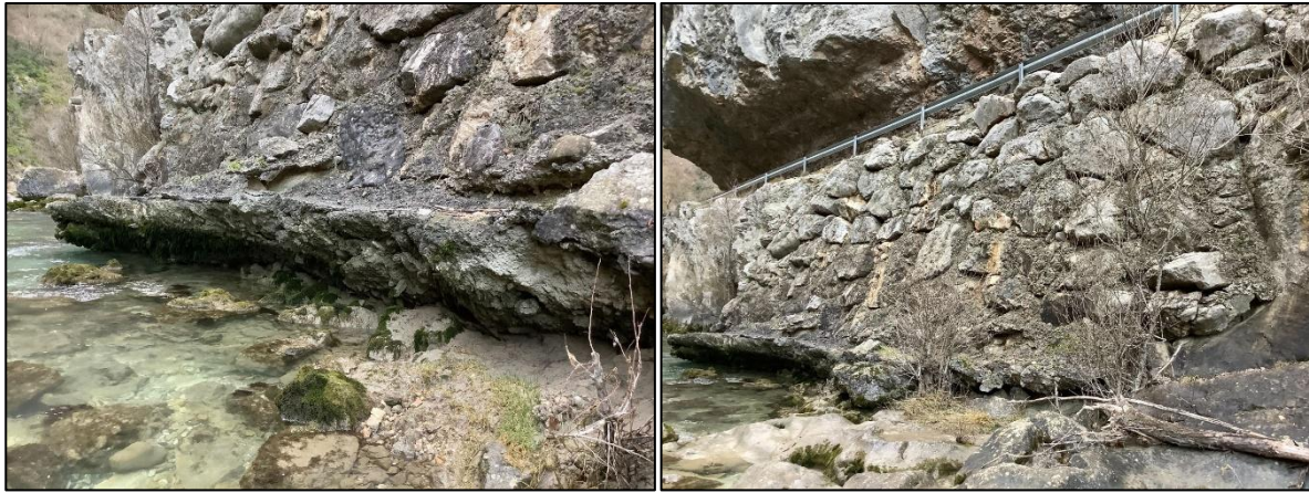
Figure 3 : Photographie de la portion RD952 PR8+820
