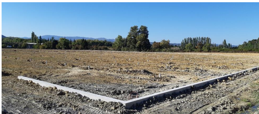
Figure 13 - Fondations béton extérieures (longrine). Reden.
