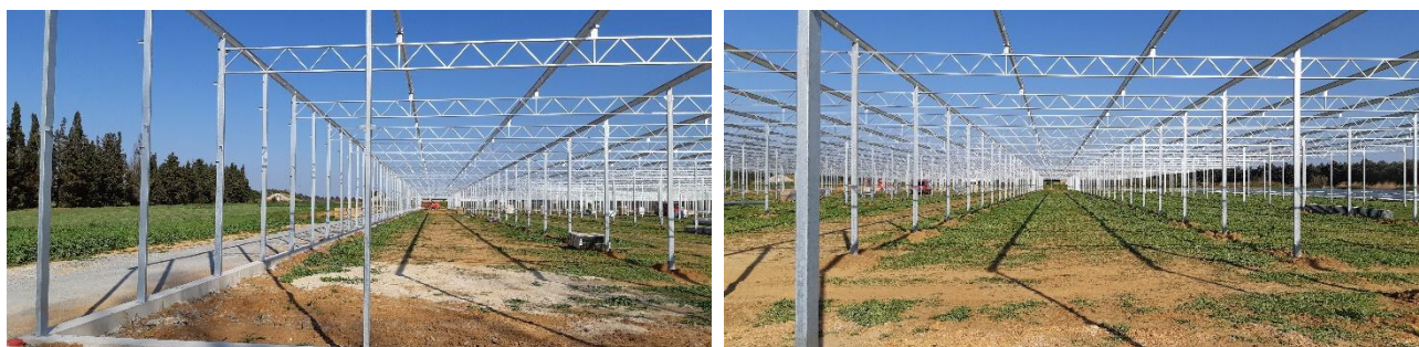
Figure 11 - Montage structure d'une serre photovoltaïque. Reden.
