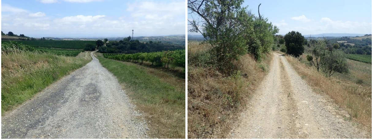
Route (à gauche) et piste (à droite) sur le site – CBE, 2024
