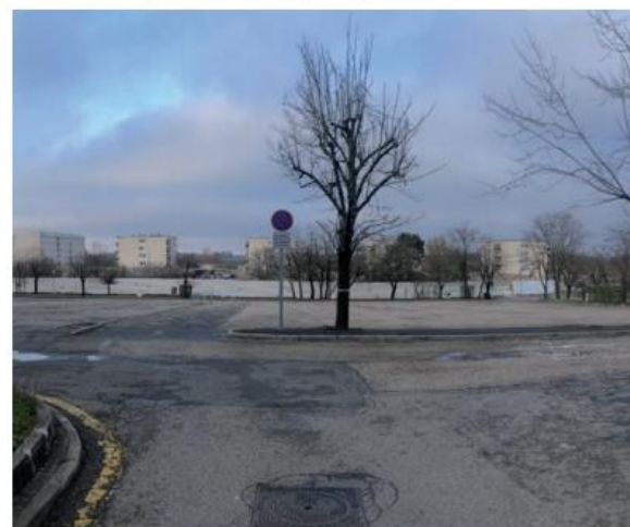
Vue 04. Vue depuis l'entrée du parking
