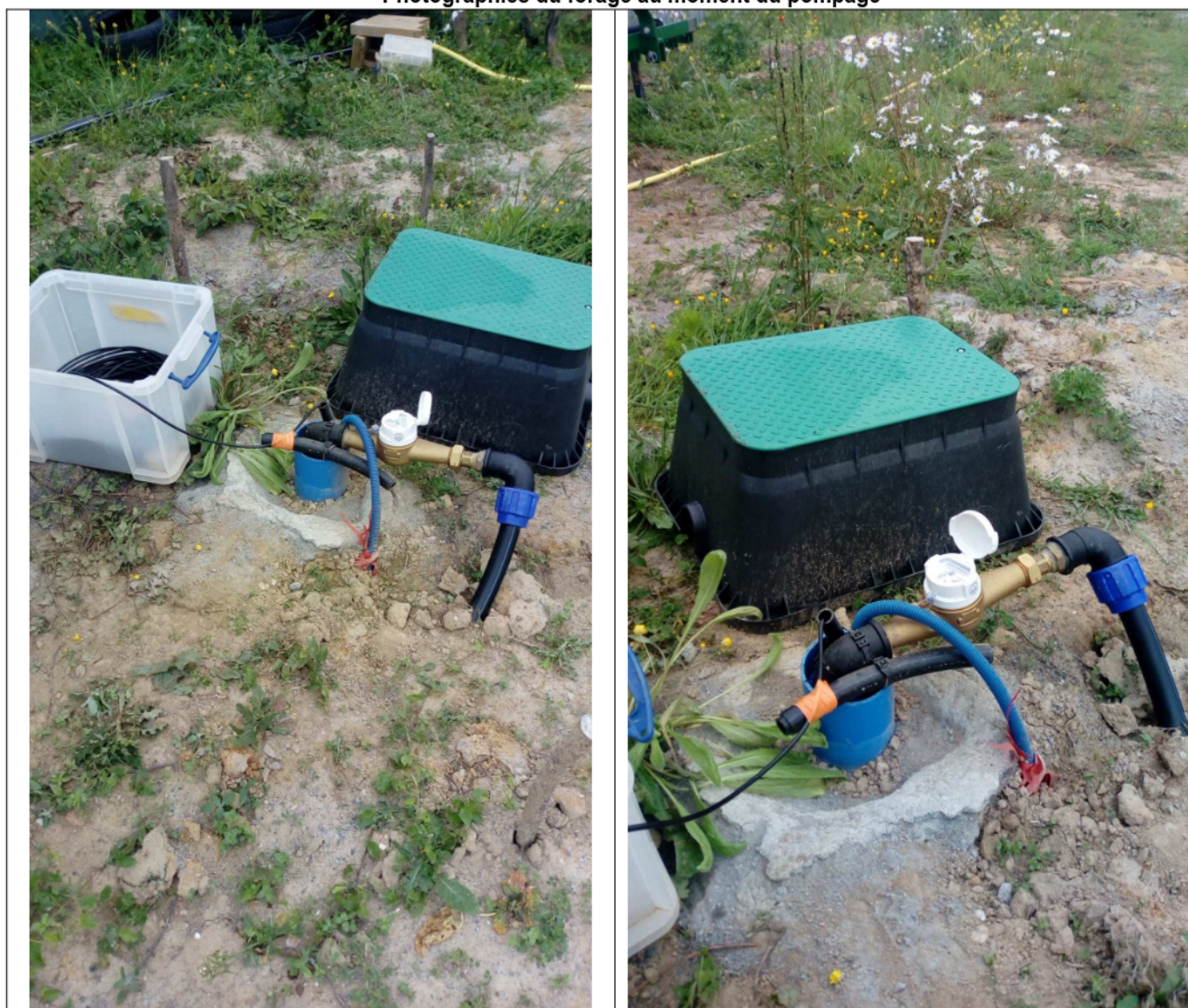
Photographies du forage au moment du pompage
