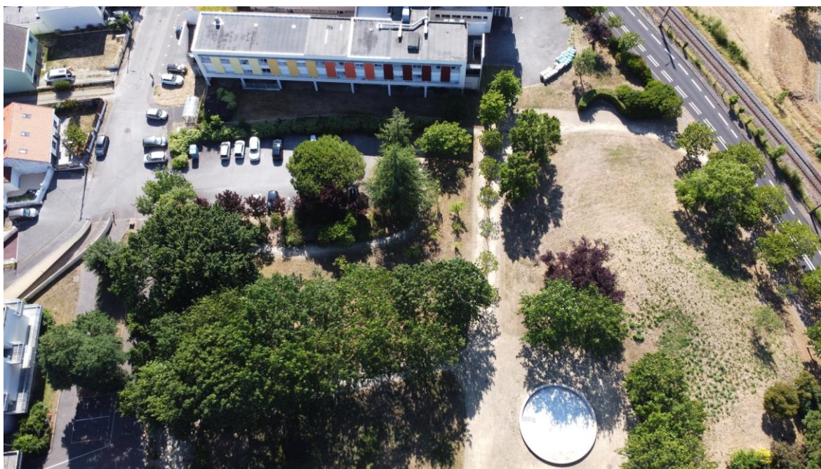
Figure 15 : Vue drone du site – partie Est
