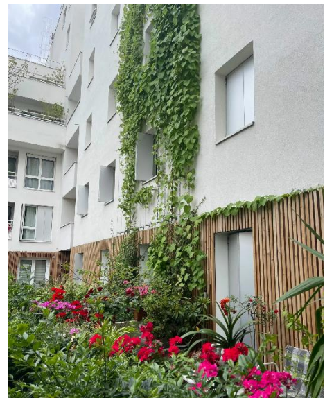
Grimpantes sur bâtiment
