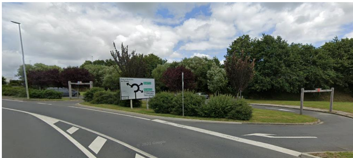
Photo 15. Aire de covoiturage située à Héric à l'entrée/sortie de la route nationale 137
