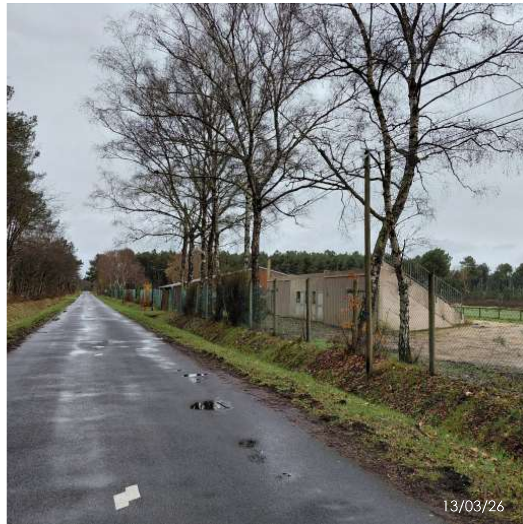
Vue 6/ Bâti existant depuis la route communale
