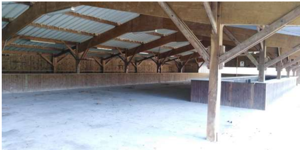
Vue intérieure de la halle
