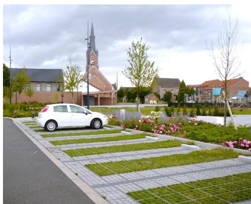
Figure 6: Revêtement perméable modulaire : Les dalles alvéolaires (ADOPTA)
