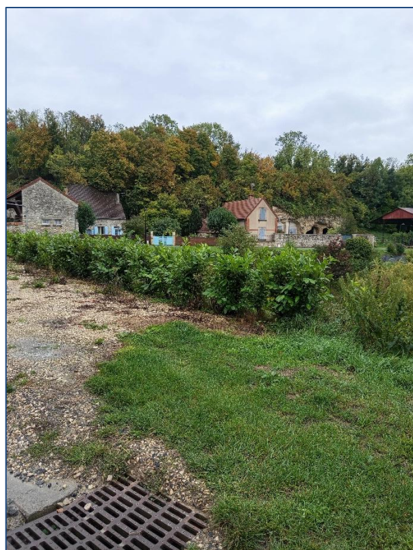
Grille rue principale avant croisement avec la rue de la Croisette
