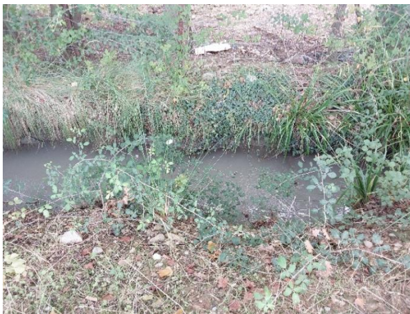
Canal secondaire en eau
