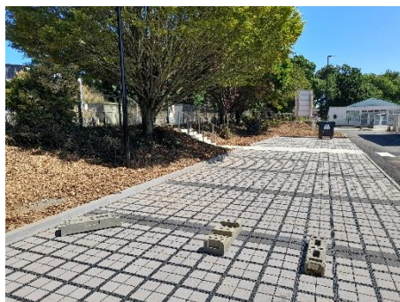
Stationnements pavés drainant
