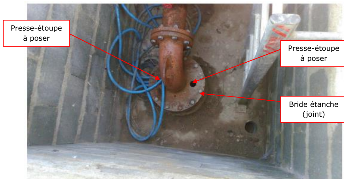
Figure 8 : Tête de puits du captage 02937X1039 (photo Utilities Performances – Juillet 2016)
