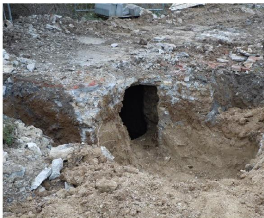
Figure 12 : Hors-sol du forage 02937X2004 à combler selon préconisations (photo Utilities Performance de Juillet 2016)
