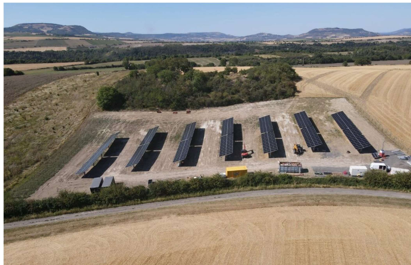
Figure 33 : Vue aérienne du chantier du démonstrateur de Chadeleuf (Source : TSE)
