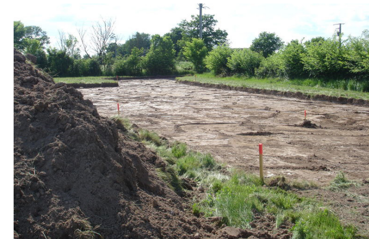
Décapage terre végétale
