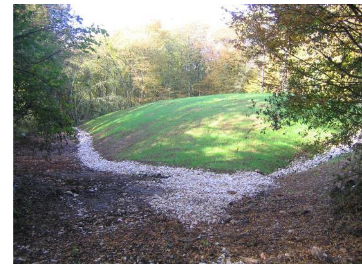
Ensemencement des terres végétales
