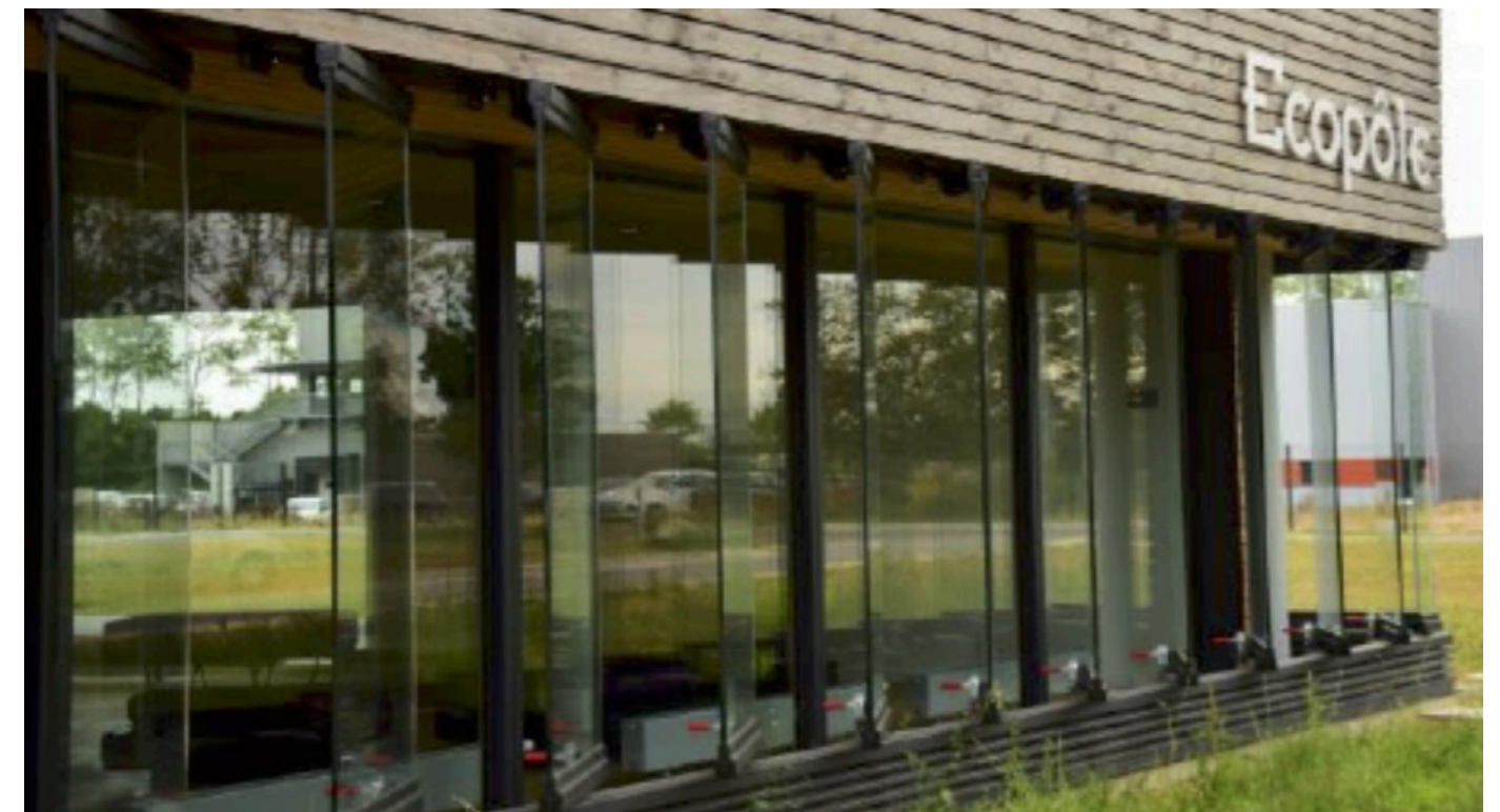
Serre bioclimatique, ventelles ouverte en période d'été (Ecopôle de Concarneau)
