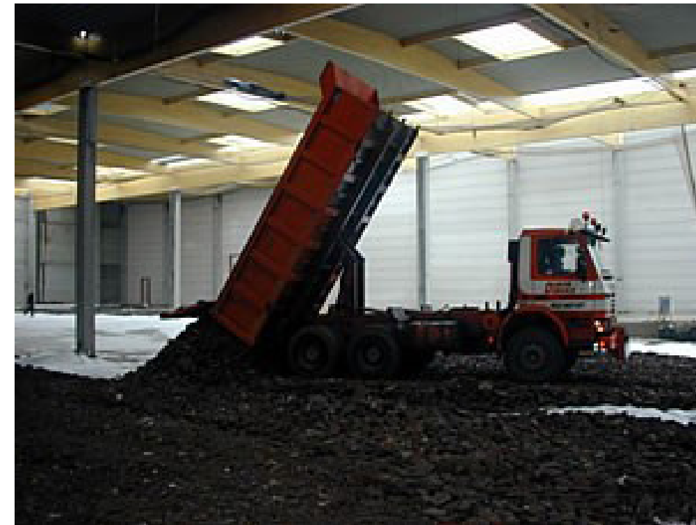
Réutilisation de granulats en couche de sous-fondation
