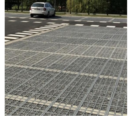
Solution perméable OzD - dalle alvéolaire gravier ( Stationnement du personnel ).
