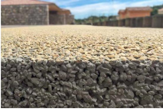
Béton drainant ( Parvis & cour de récréation ).
