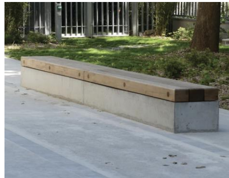
Assises bois simple sur bloc béton (cour de récréation).
