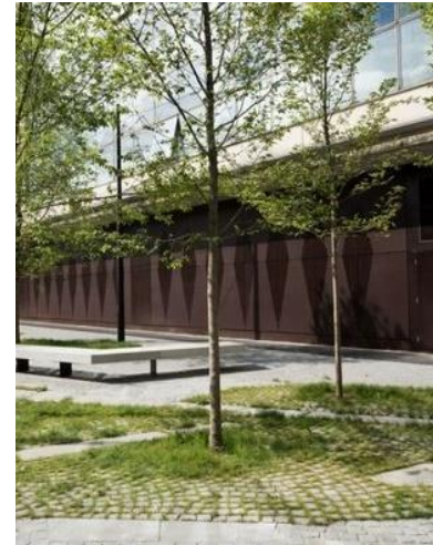
Pavés béton enherbé ( cour de récréation ).
