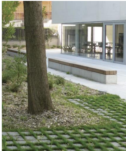
Pavés béton enherbé ( cour de récréation ).
