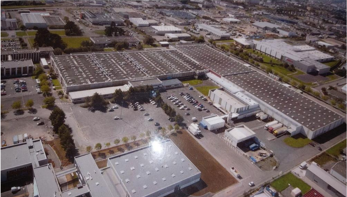
VUE AERIEENNE GLOBAL DU SITE
