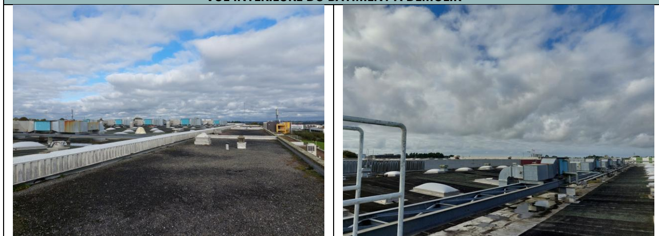
VUE DEPUIS LA TOITURE DU BATIMENT A DEMOLIR
