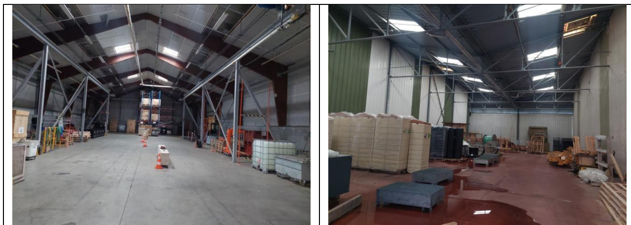
VUE INTERIEURE DU BATIMENT A DEMOLIR
